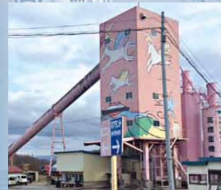
生コンプラント
